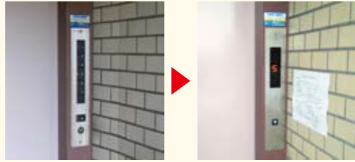
乗場用操作盤取替 文字でハッキリ表示されるため、運行状況が大変見やすくなります。また、「点検中」など文字情報も表示されます。
