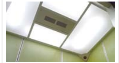
吊り天井（LED照明） 近代的なイメージになり、LEDで省エネ。 エレベーター内がとて明るくなります。
