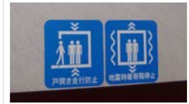
戸開走行保護装置 (停電管制装置付き) 2重ブレーキで安全性を向上します。停電時に最寄り階へ停止する機能付きです。
