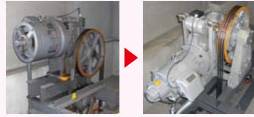
巻上機一式取替 電動効率の良い最新式の巻上機でモーターもコンパクトになります。
