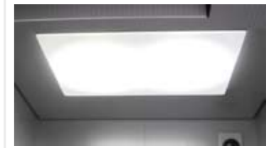
LED 照明 既存の照明器具を LED に置換えます。省エネに貢献します。
