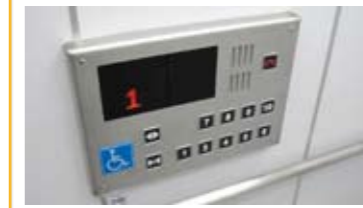
副操作盤 かご内側面に操作盤を追加できます。車いすでの利用が大変便利になります。
